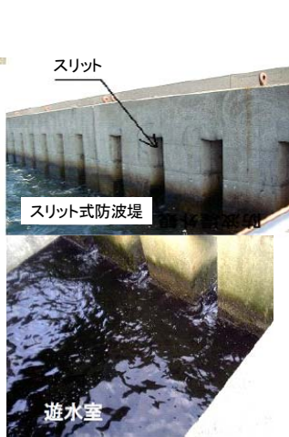
図1 スリット式防波堤
